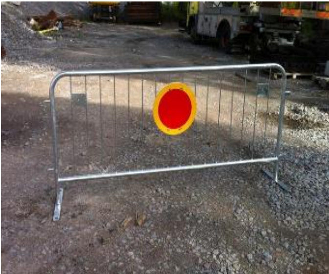
Bild: Varningsstängsel med hindertavla
